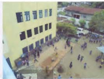
Teilpflasterung des Schulhofes..
