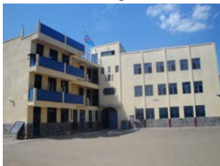
2015: Erweiterung der Schule
