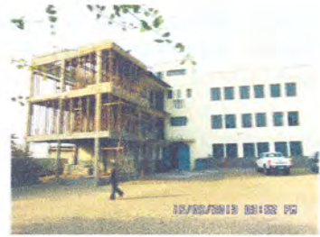
Erste Erweiterung der Schule
