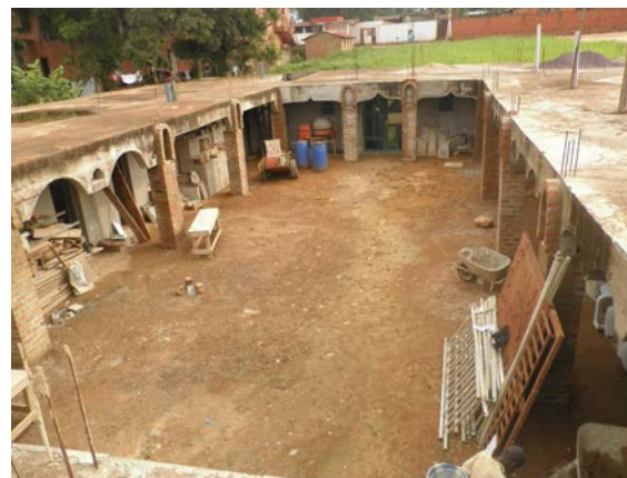
Ein im Bau befindlicher Konvent mit 20 Zimmern für Hikaf-Studenten
